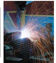
鋼板フレーム溶接ライン
